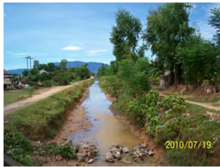
SPL 水路の上流に位置する アースライニング水路
