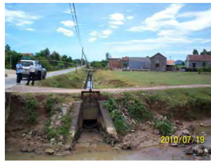
SPL 水路への分水路
