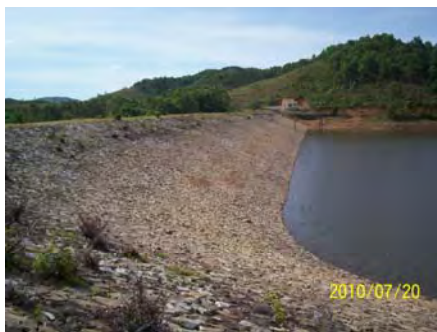
An Hung ダム・貯水池
