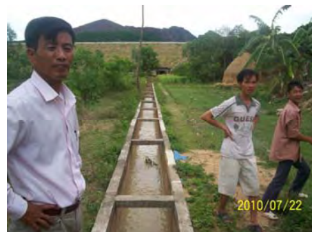
幹線コンクリートフルーム水路
