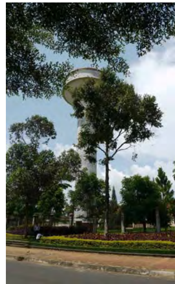
高架配水タンク
