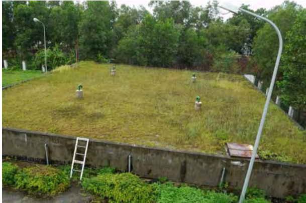
半埋設型配水池
