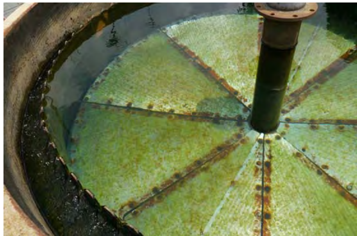
上向流ろ過池
