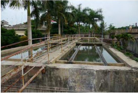
横流式薬品凝集沈殿池
