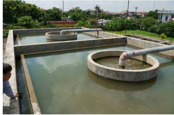
高速凝集沈殿池（上向流沈殿池）
