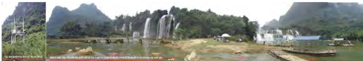
図 6.2-8 SPL III において建設された 50kVA 変圧器により電力を供給されている Ban Gioc 滝
