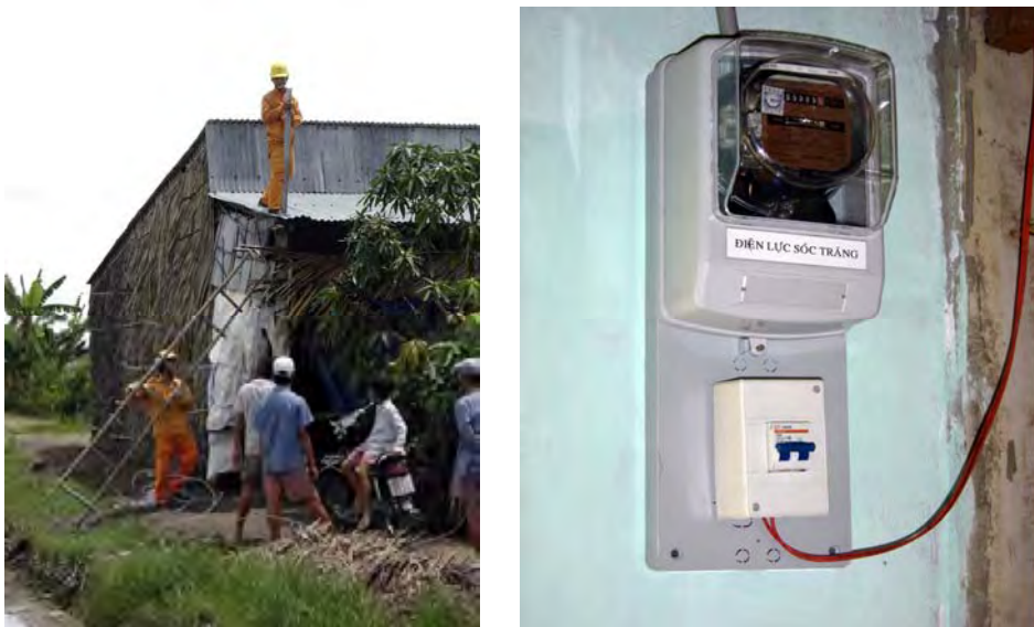
図 4.1-6 Soc Trang 省 My Xuyen 郡の Thanh Phu コミューンで一般家庭への引込線接続工事を行っている My Xuyen 電力会社の作業員
