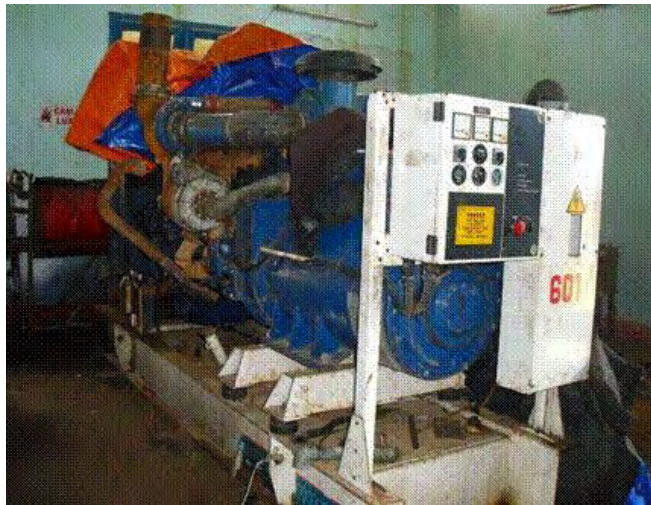
図 6.1-1 Ly Son 島の故障中ディーゼル発電機
