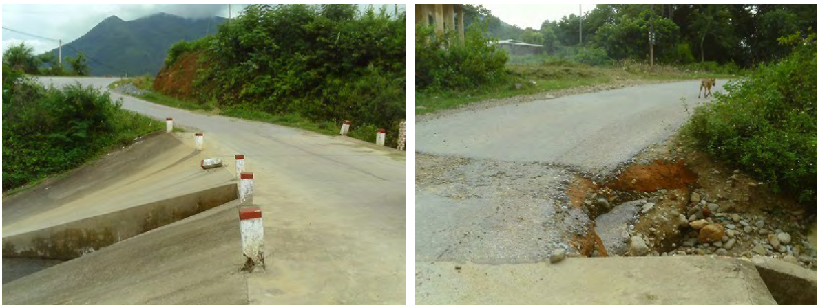
図 4.3-18 Km 6+500 付近のスピルウェイ（潜水カルバート）状況
