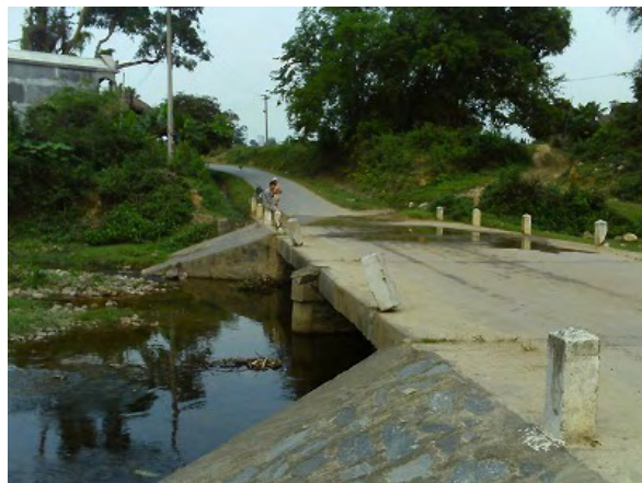
図 4.3-2 Km 26+200 付近の潜水橋
