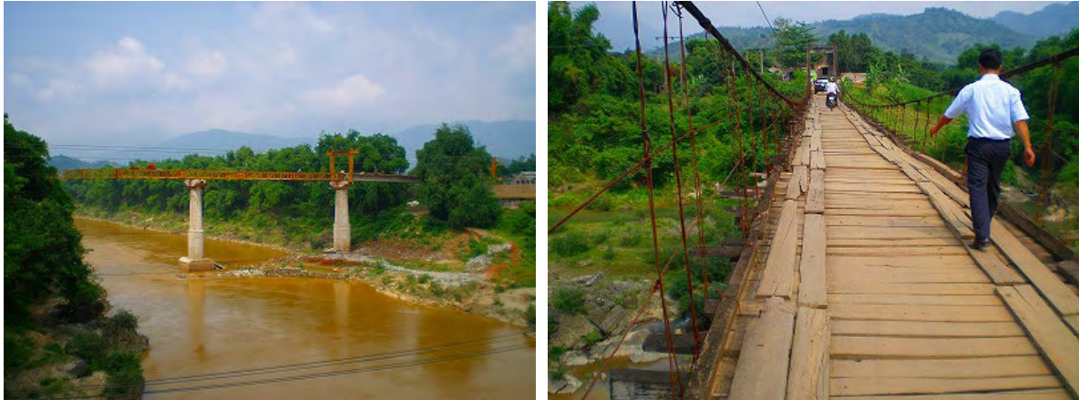
図 4.3-10 施工中の橋梁及び老朽化している吊り橋
