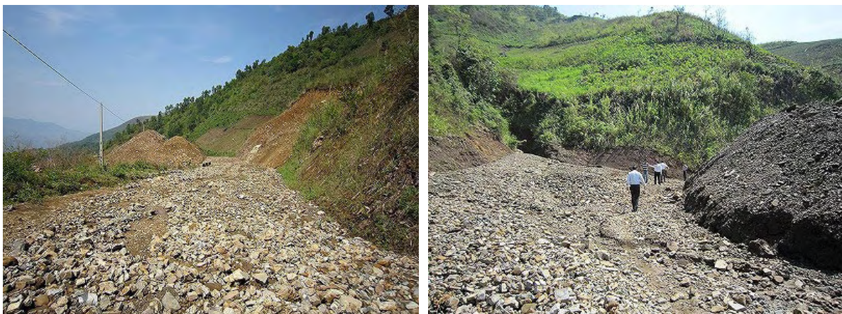
図 4.3-4 Km 16 付近の土砂堆積状況
