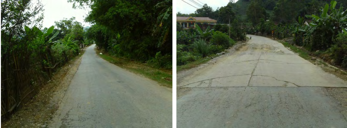
図 4.3-13 Km 114+50 付近の標準的な状況、および局部的損傷を受けた状況
