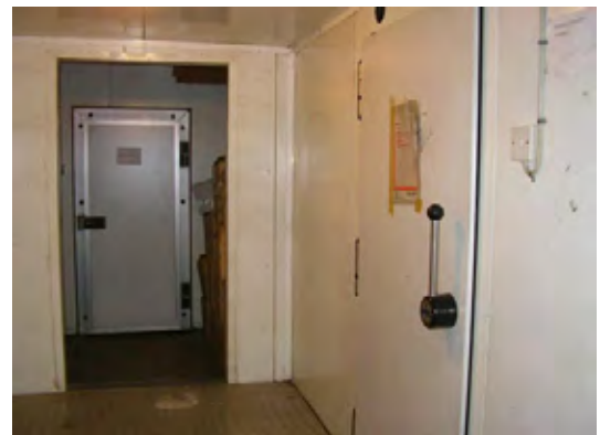
コールドルーム、フリーザールーム収納倉庫内部：既存のコールドルームとフリーザールームは老朽化により移設不能である。
