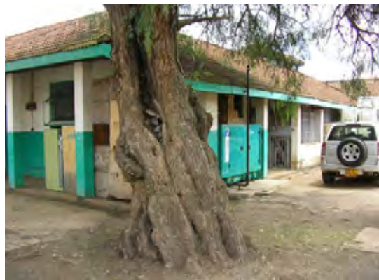
コールドルーム、フリーザールーム収納倉庫外観：国立感染症研究所の一部の室を借用している。
