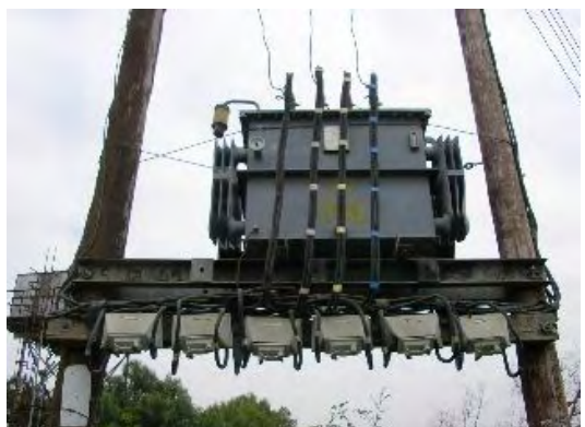
隣接トランスフォーム:本計画施設のこのトランスフォームより電源の供給を受ける。
