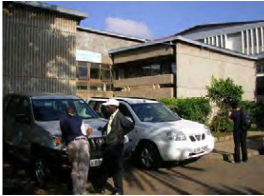
事務所外観：複数の組織 / 機関が共用で使用している。
