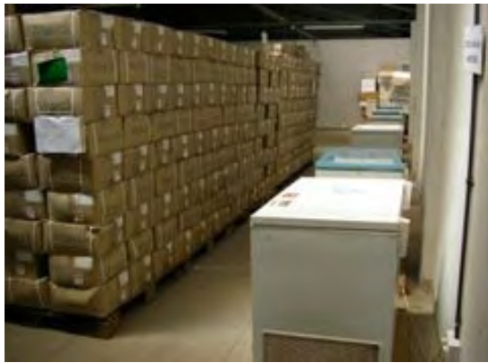
フリーザールーム:老朽化により他の保管庫で使用予定。
