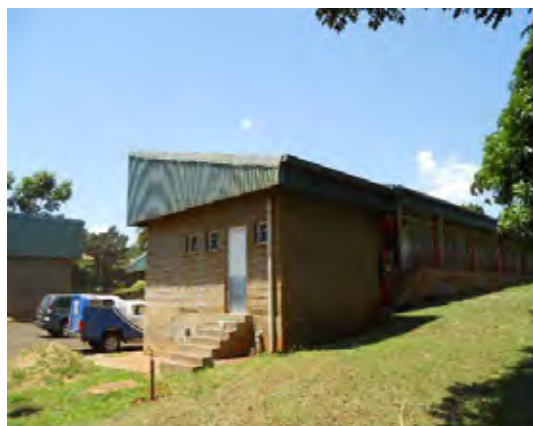
KEMSA事務所外観：KEMSA事務所と便所棟の外観。
