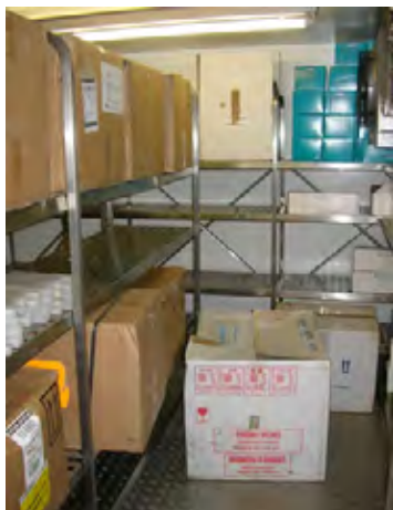
コールドルーム内部：鋼製収納棚を設置してワクチン等を保管している。
