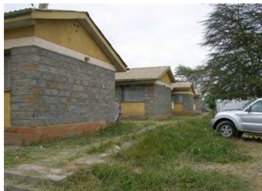
ヘルスセンター職員宿舎外観:ヘルスセンタースタッフ用宿舎で3棟建っている。
