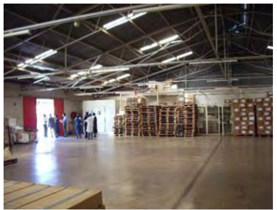
倉庫内部:DVIコールドルーム1台が収納されている。
