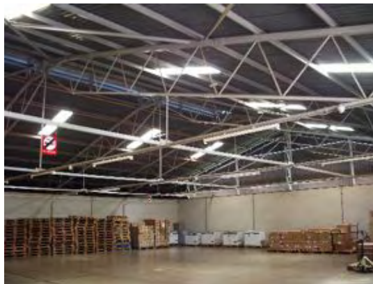
倉庫内部:DVI冷凍庫5台が収納されている。
