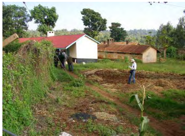
計画敷地（西側）：計画敷地内に建つ既存倉庫2棟。現在使用されておらず、現地側で解体・撤去予定である。敷地は緩い勾配がついている。
