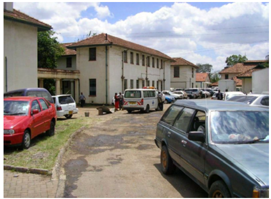
冷凍庫収納倉庫外観：国立感染症研究所の一部の室を借用して冷凍庫等を収納している。
