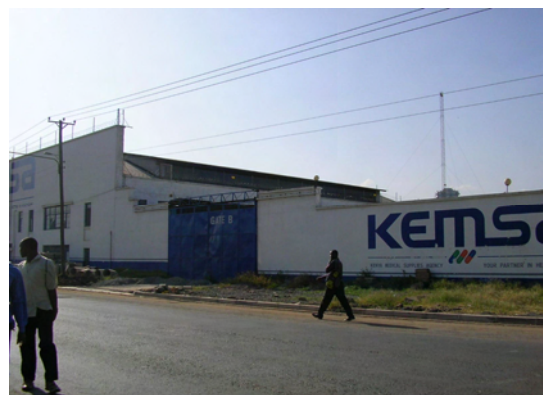
KEMSA倉庫外観：KEMSA倉庫の一角を借用し、保冷库、保冷ボックス等の大型ドライストレージ物品を保管している。
