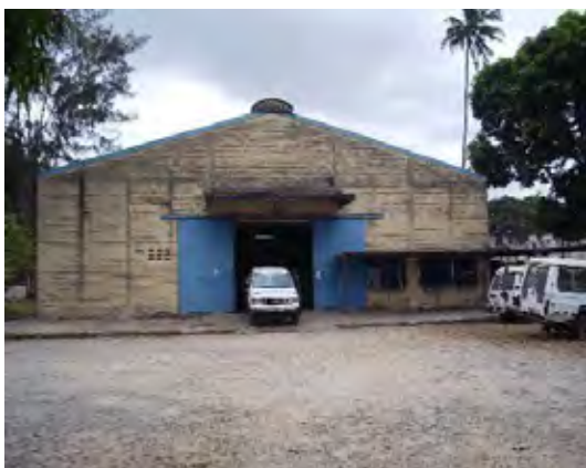
KEMSA倉庫外観:KEMSA倉庫入り口にローディングベイは設置されていない。
