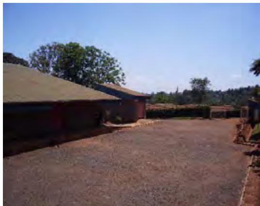
KEMSA倉庫外観：KEMSA倉庫と駐車場。
