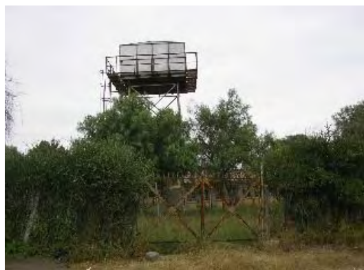
ヘルスセンター敷地内高架水槽:本計画施設もこの高架水槽から上水の供給を受ける。
