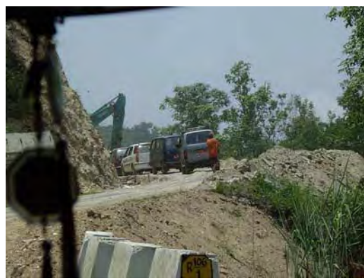
写真12：拡幅工事、サルパンへ向かう道路
