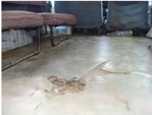
写真 3：レゼブ病院の更新対象車両内部、ストレッチャーが取り外され、床の痛みがひどい。
