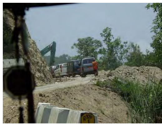
写真12：拡幅工事、サルパンへ向かう道路
