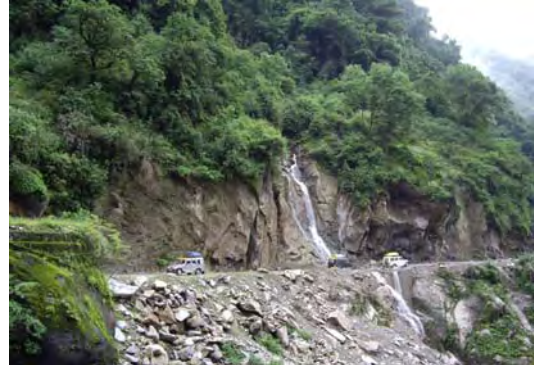
写真8：モンガルの道路、滝の水が道路を横断している。
