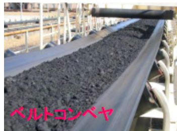
ベルトコンベヤ 能力 2,400 t/h, 全長約 900m 出所：東京電力（株）
