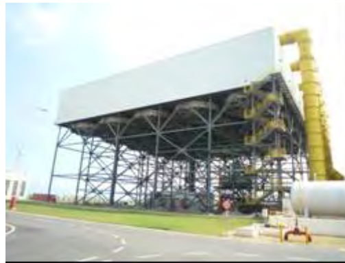
図 14-9 強制通風空気冷却設備系統と実装例
