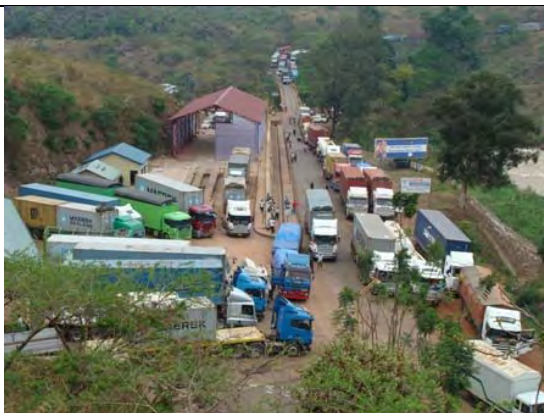
写真-5：既設国境施設は十分な駐車場がないため道路上に大型車両が駐車。（ル国側国境施設）
