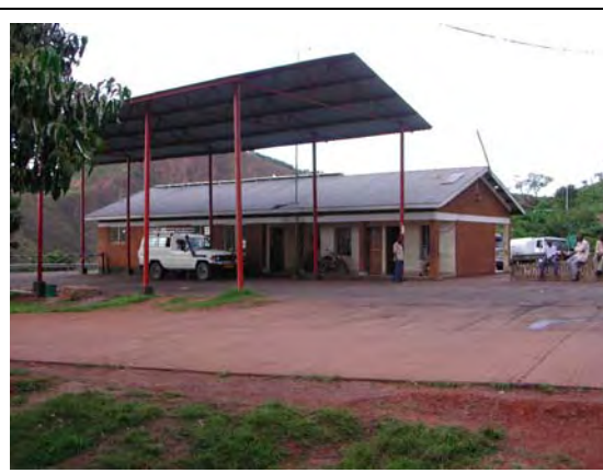
写真-8：「タ」国側税関事務所は、平屋レンガ造りである。
