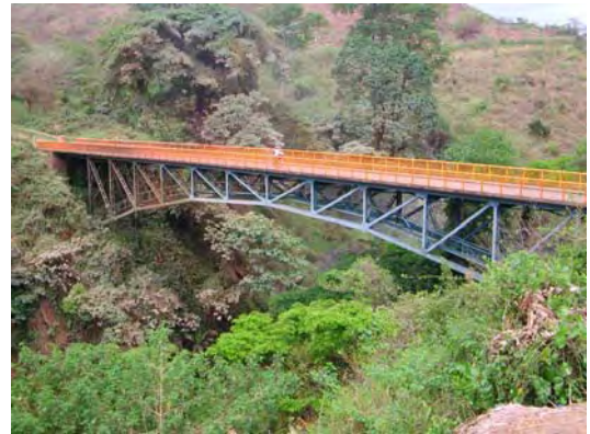
写真-2：「ル」国側下流側から見た既設橋。上流側にルスモ滝があり河川両側斜面は急勾配を成している。
