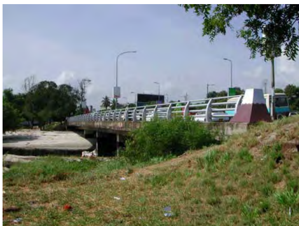
写真2-1 スレンダー橋
