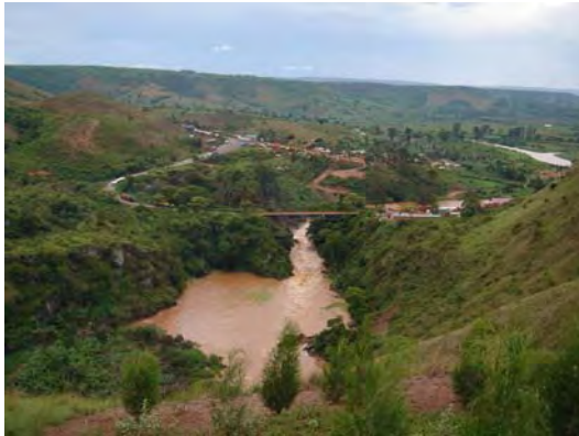
写真-1：下流側丘陵から見た既設橋と左側が「タ」国の国境施設、右側が「ル」国の国境施設の一部が見える。新橋は下流側（写真手前）に設ける。
