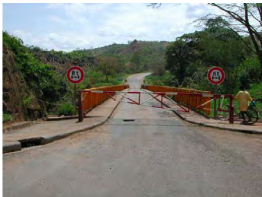
写真-3：既設橋は1車線で車両の軸重制限8トン、速度制限5km/hr（警察が監視）がとられている。
