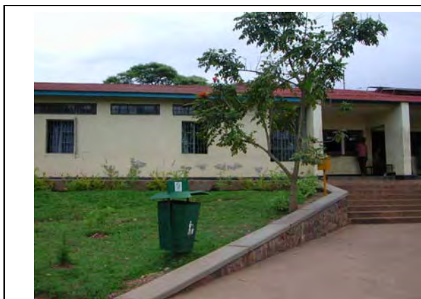
写真-7：「ル」国の税関事務所は、平屋レンガモルタル壁で混雑時には窓口に行列ができる。
