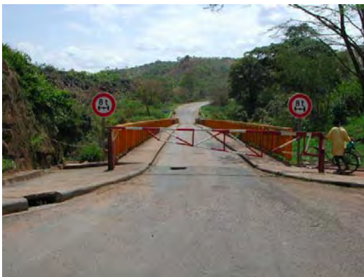
写真-3：既設橋は1車線で車両の軸重制限8トン、速度制限5km/hr（警察が監視）がとられている。
