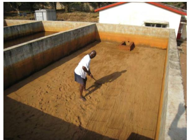
写真 16：緩速ろ過池の砂掻き作業
