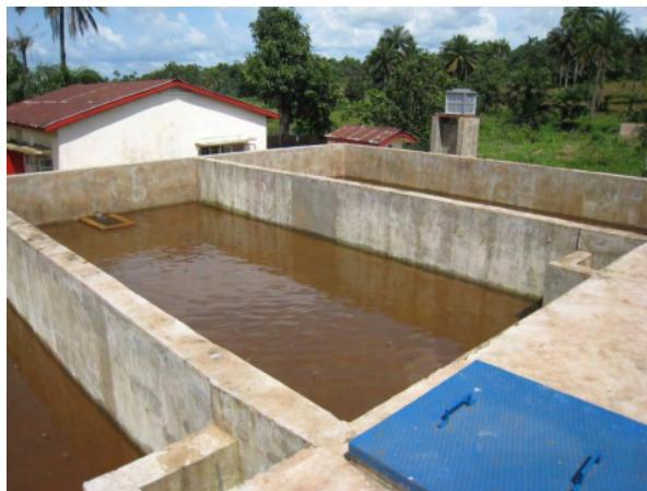
写真 15：ロクプール浄水場の緩速ろ過池
