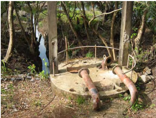
写真3：コレンテン川既存取水施設 既存浄水場の取水施設。内戦中に破壊されたが、本プロジェクトで修復して使用する。
