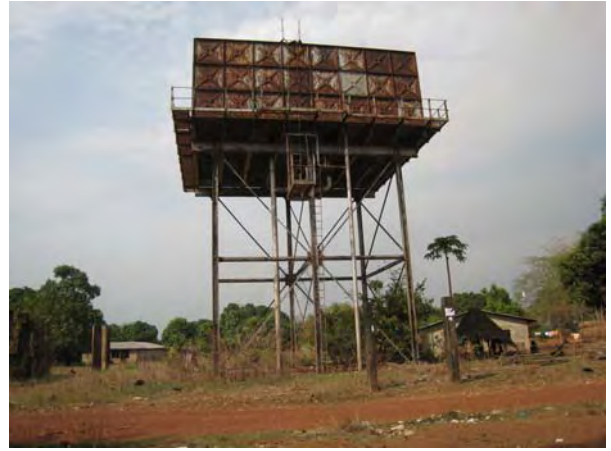
写真 8：既存高架水槽
