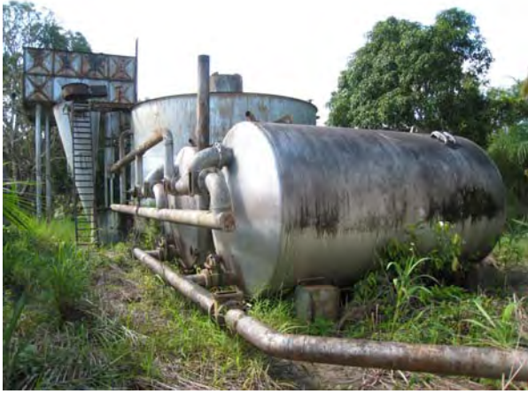
写真 7：既存浄水設備
