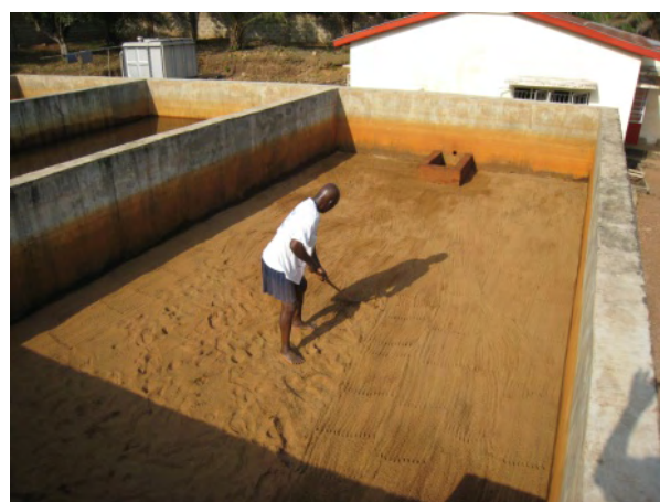
写真 16：緩速ろ過池の砂掻き作業 緩速ろ過池は定期的にもろ過砂の表面を掻き取って、ろ過機能を回復させる。
