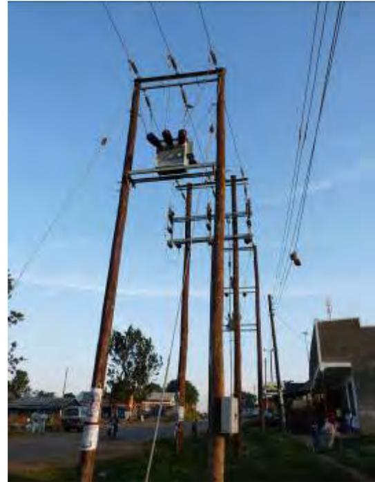
REA 側も同様に VT、CT を設置して配電線の電力量を計量中
