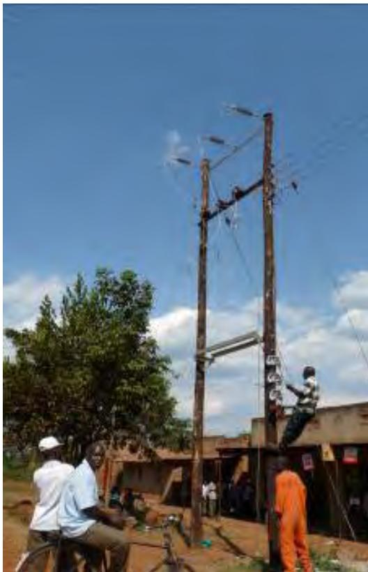
電化エリアで新規に変圧器を設置する工事の様子。現場監督と施工人が各1名の2名体制
