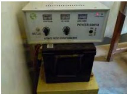
撤去した太陽光のバッテリーはインバータを介してグリッド電源により充電して今も使用中。停電時はバックアップ電源となる
