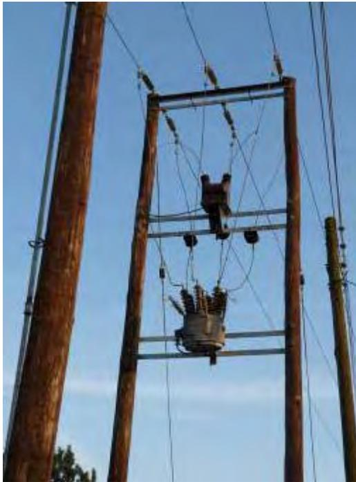
南端の Kyotera。世銀の支援で建設された 33kV 線路と REA 自己資金で建設したルートに分界点に VT、CT を設置して計量中
