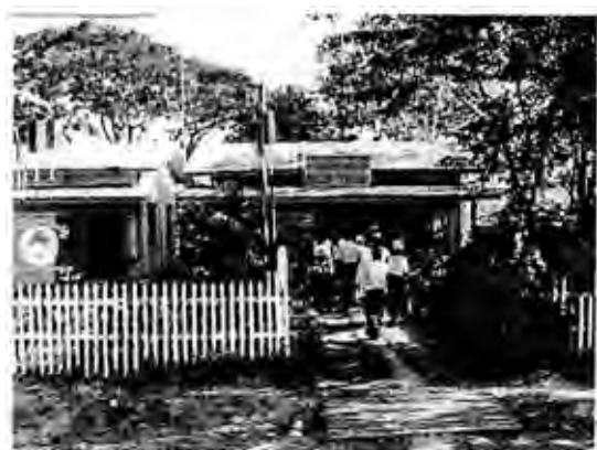
11. 同 RHC が管轄する 5 つのサブ RHC の 1 つである Thar Yar Kone サブセンターの外観。
