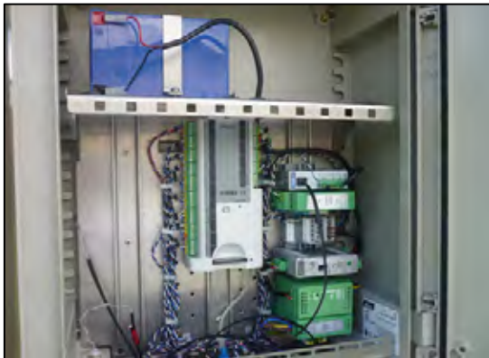
ロガー (Bacos) データ処理ユニット及びデータロガー。太陽電池を併用したバッテリーで電力を供給している。
