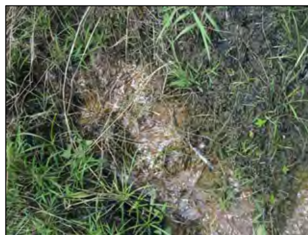
Citrakoot 地区の地すべり末端部 末端部では、軟弱な土砂からの赤褐色湧水が認められ、地下水が十分にあると考えられる。
