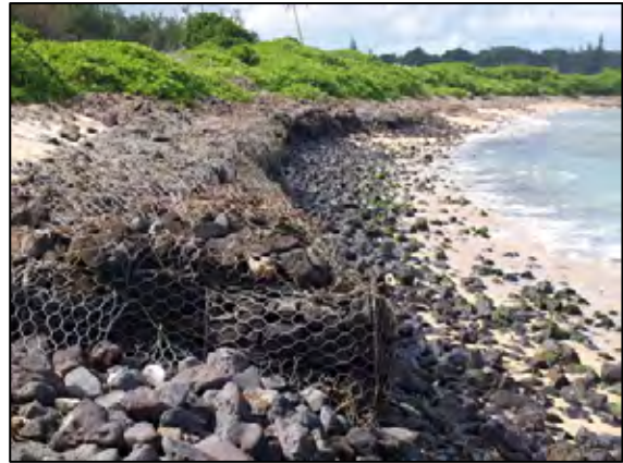
海岸浸食防止のための蛇かご (Souillac) さんご礁のない海岸線では、海岸浸食が顕著に進んでおり、 蛇かご対策を講じている地域もある。
