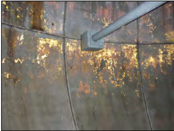
旧気象ドップラーレーダー・レドーム内部 (Trou aux Cerf) レドームは、強化プラスチックで作られており、老朽化し ているもののヒビや穴などの破損はない。
