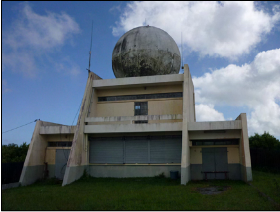
旧気象ドップラーレーダー全景 (Trou aux Cerf) MMS から約 3km 離れたクレーターの外輪部に位置する。 建屋自体は堅固に作られており、現状でも利用可能である。
