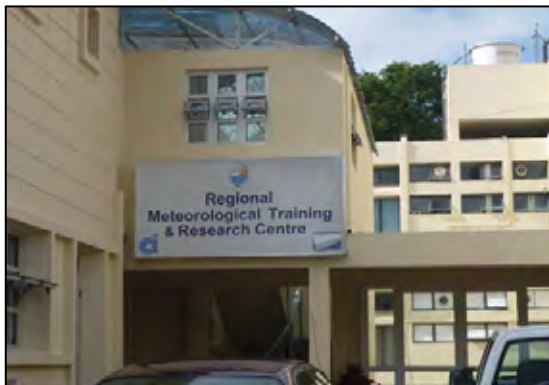
地域トレーニングセンター (Bacos) IOC の予算で、本部の別棟に整備された。右奥の建物は、MMS の管理棟。
