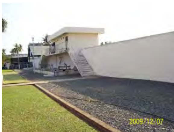
第 2 配水池建物
