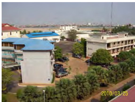
プンプレック浄水場構内(2)
