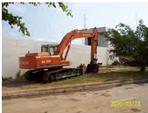
第 3 配水池建物
