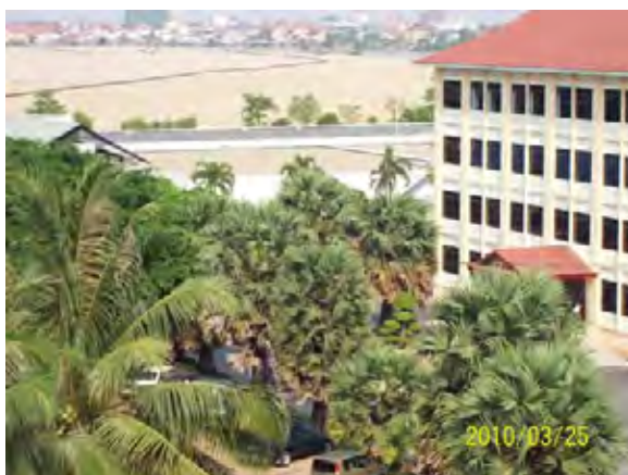
プンプレック浄水場構内 (1)
