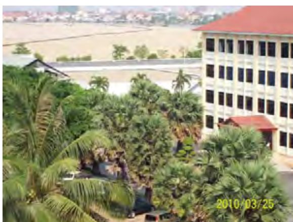
プンプレック浄水場構内 (1) 奥に見える茶色及び灰色部分が今回 PV システムを設置する第2及び第3配水池屋上。赤屋根は今年完成した新建物。
