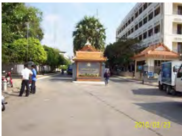
プンプレック浄水場正面入り口 PPWSA が管理する浄水場、PPWSA はここを含めて3つの浄水場を運営している。
