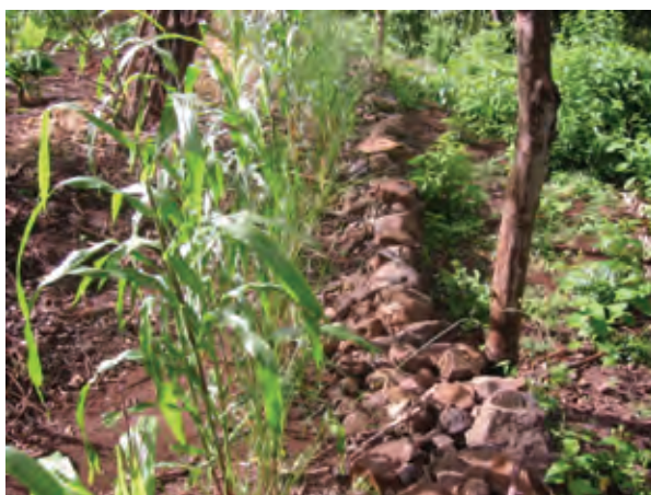
－耕作地改善のための土壌保全工（石積工）－
