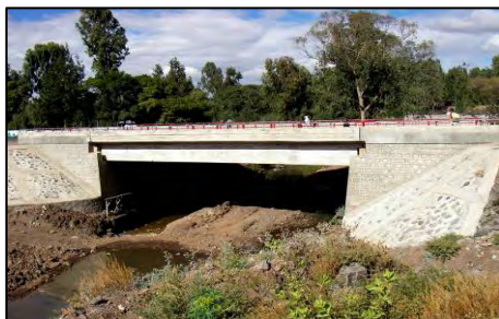
写真 2-2-3 デュケム橋（全景）
