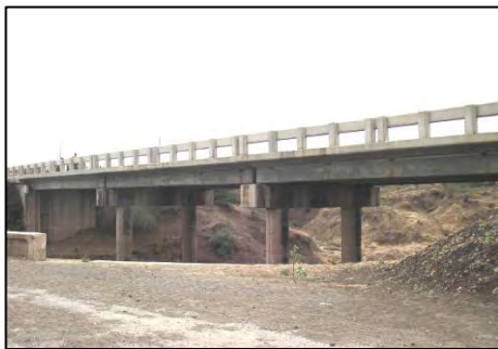
写真 2-2-1 メルカレミ橋（全景）
