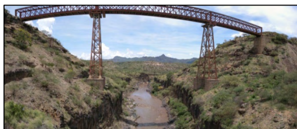
上流側（鉄道橋の基礎部は低水路の上部に位置）
