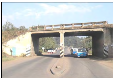
写真 2-2-8 ボックスカルバート
