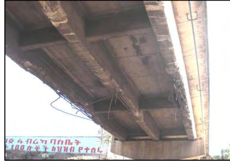
写真 2-2-11 車両衝突により損壊した主桁
