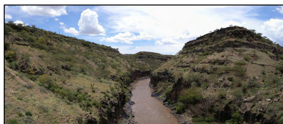
下流側（低水路の川幅はほぼ一定）
