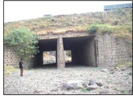
写真 2-2-5 ブルカレゴ橋（全景）
