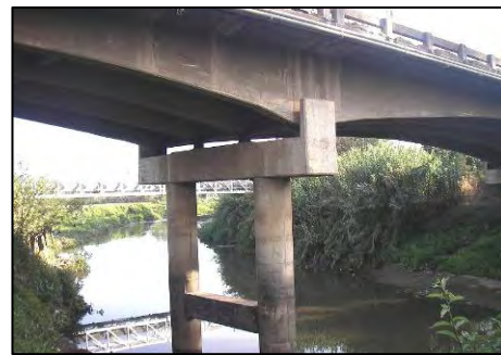
写真 2-2-7 非常に細い橋脚
