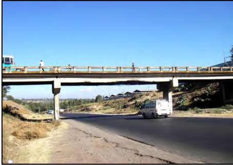
写真 2-2-10 国道1号線上の跨道橋)
