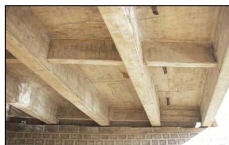
写真 2-2-4 デュケム橋の主桁と床版
