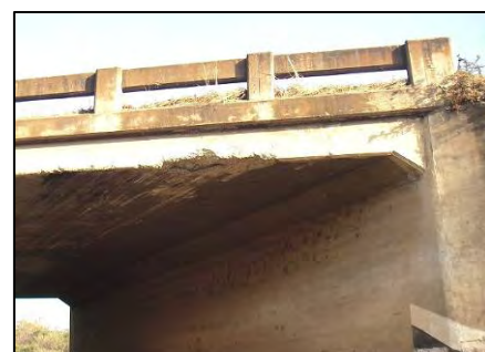
写真 2-2-9 車両衝突により損傷した上床版
