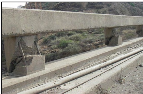
写真 2-2-12 水道管と電気・通信ケーブル
