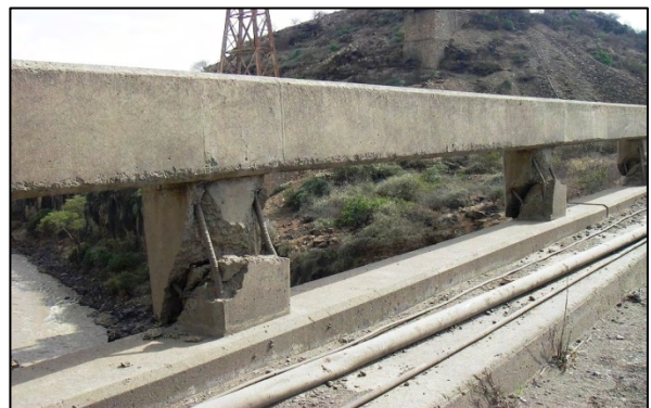
写真 8：車両の衝突により損傷した高欄
