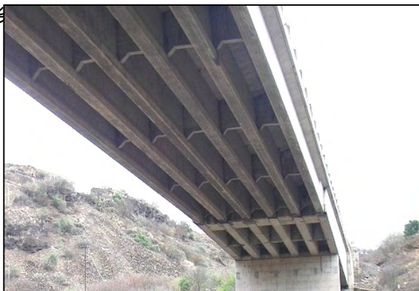
写真 5：非常に薄い主桁腹板厚
