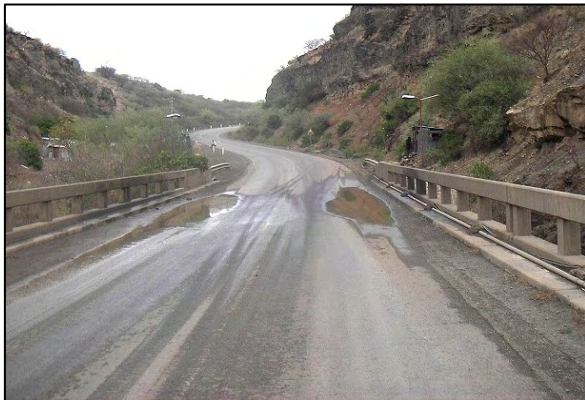
写真 3：橋面舗装のわだち掘れに溜まった雨水
