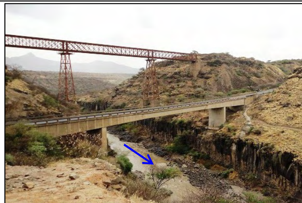
写真 15：上流はスペースがないため下流に架橋
