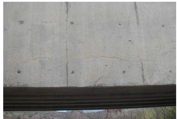
写真 6：主桁に見られるひび割れ
