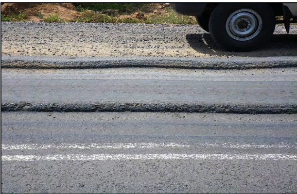
写真 13：アワシユ橋取付道路に生じている轍掘れ
