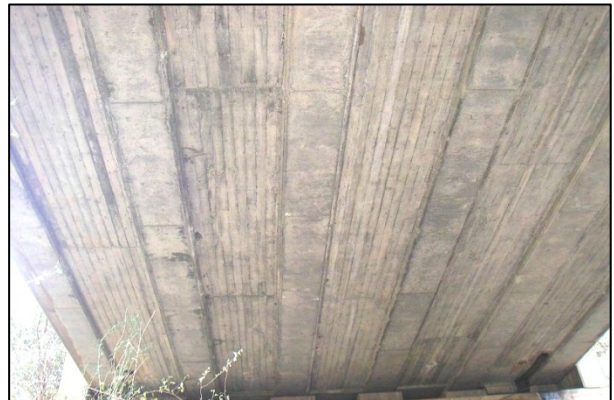
写真 4：劣化の進む主桁下面
