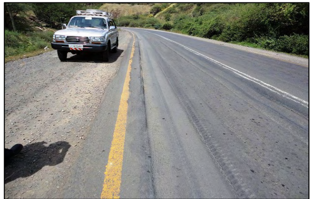
写真 14：急カーブ、急勾配に起因する轍掘れ
