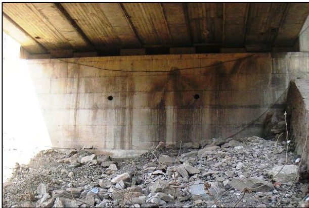
写真 11：劣化し、変色の顕著な橋台
