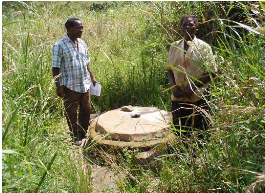
ネノ県：ハンドポンプ付の浅井戸があったが、水位が低下して空井戸になったので、利用していない。
