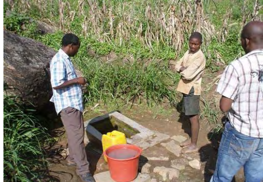
ネノ県：保護施設付の手掘り井戸。湧水地点に設置されている。深さは1mほど。白濁している。
