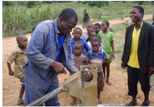
ムワンザ県：エリアメカニックによるハンドポンプの修理状況。
