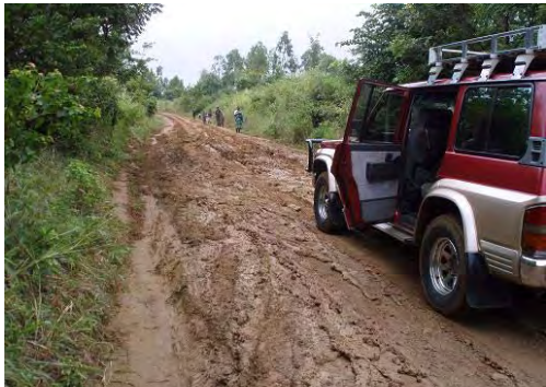
ネノ県：ネノ県庁へ向かう主要道路の降雨後の状況。降雨後、1日経過しても4WD車両が横滑りする。
