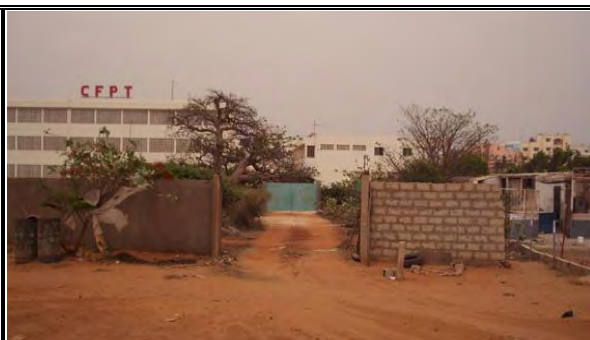
写真-21：既存門扉外観 同左既存門扉をV.D.N.通り敷地の外側より望む 背後の建物はBTS教室・実習棟
