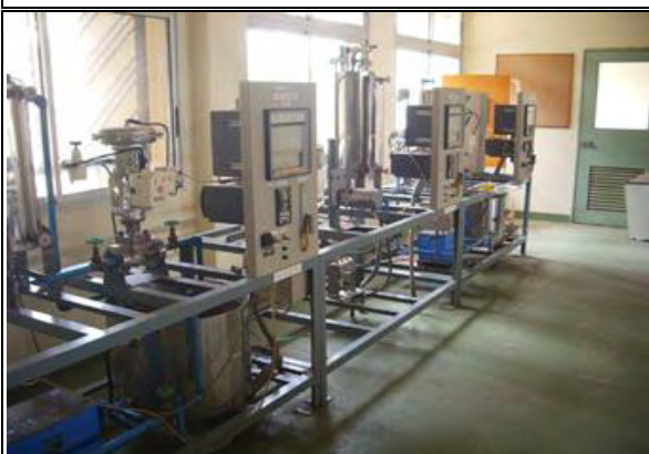
写真-11：電子実習棟 1階実習室 水力発電シミュレーター：1984年の無償資金協 力にて整備。現在も稼働中
