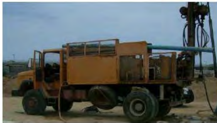
Photo 5 : Réalisation du sondage C
