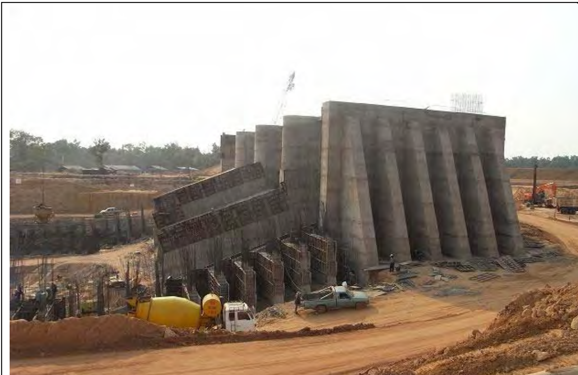
Lam Pao Dam の余水吐の新設（カラシン県）。新設余水吐は4門ラディアルゲートで、高さ7.70m、幅12.5m、最大放流可能量 2,216\text{m}^3/\text{s} である。
