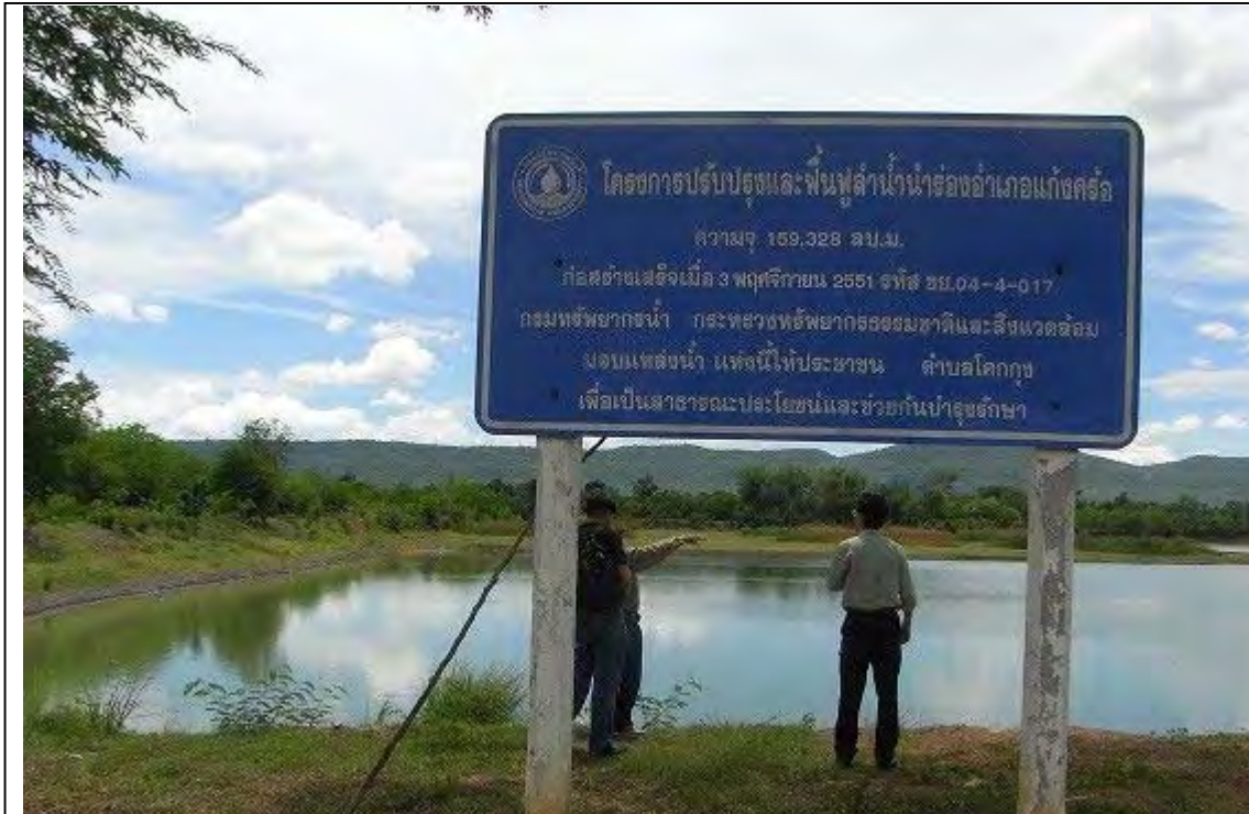
チャイヤプーム県の Huai Sam Mo 地区におけるため池。6 村で飲料水に不足をきたしていたため、2008 年に飲料水用のため池の改修工事が実施された（50 ライ、159,000m 3 ）。DWR より 8 百万バーツの財政援助が行われた。
