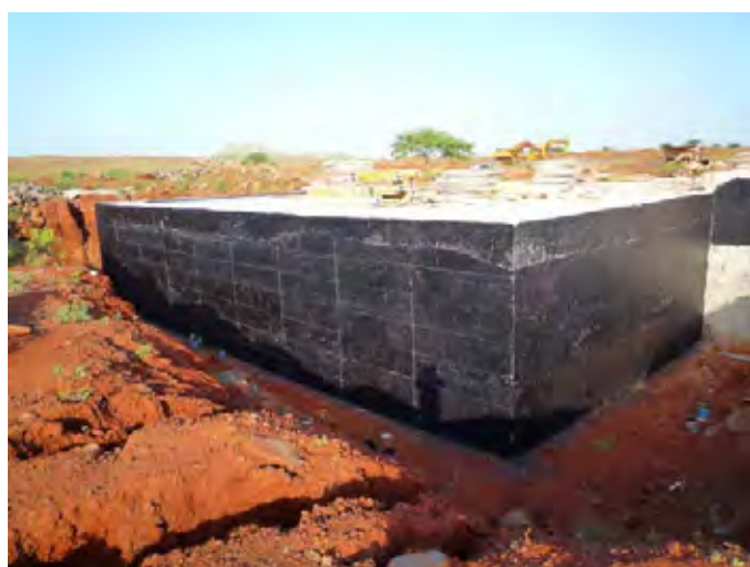
Reservatório em construção (Ribeira Grande)
