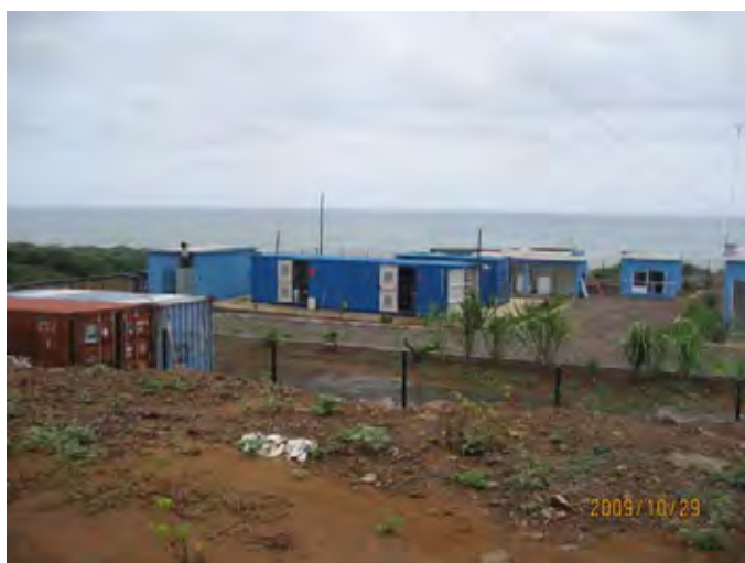
Santa Cruz usina de dessalinização
