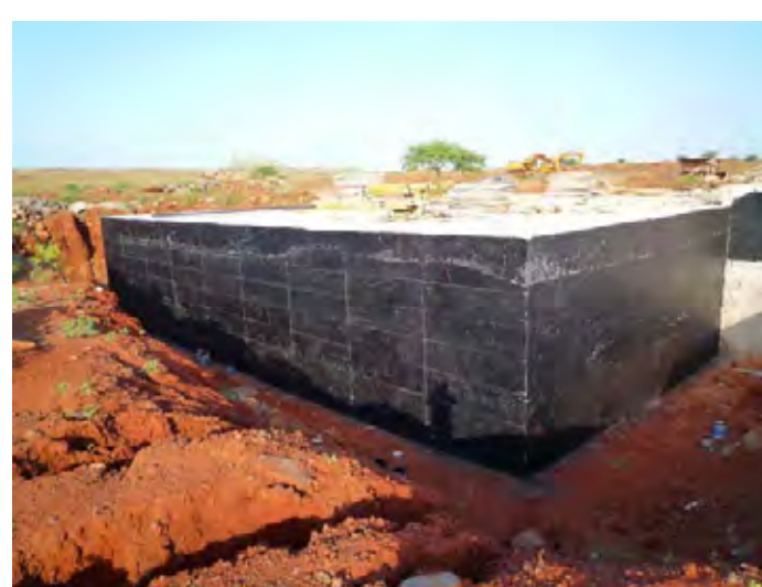
建設中の貯水槽（リベラグランデ）
