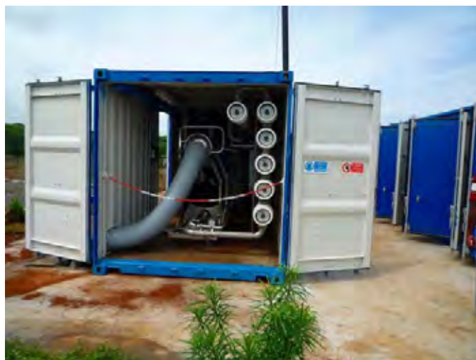
サンタクルス市近郊にある海水淡水化設備本体 (500m 3 /日、1 系列)
