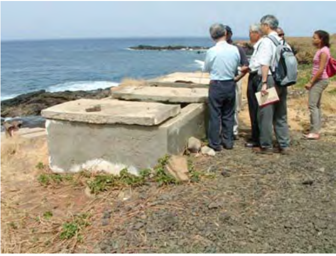
海外取水井戸（プライア市）
