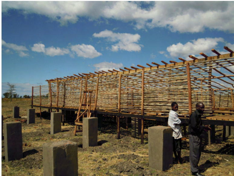
写真: 圃場内にヤギの繁殖小屋を建設中
