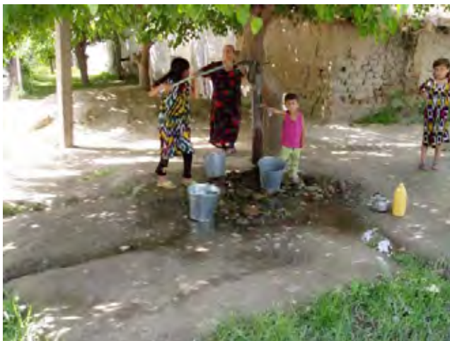
写真-7【モスクワ町のハンドポンプ】 モスクワ町の給水状況の悪い住宅街に住民の手によって設けられたハンドポンプ井戸。
