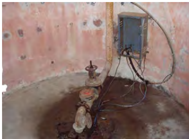
写真-2 【モスクワ町ボドカナル深井戸】 45年前に建設された深井戸。 4井の内、3井戸が稼動中である。
