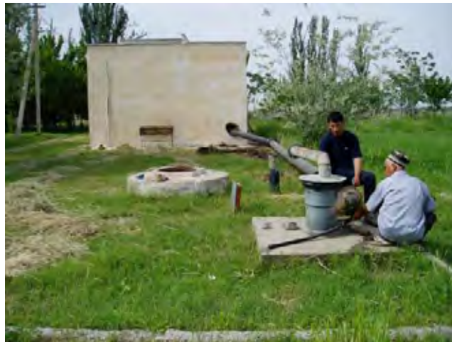
写真-8【メハナタバッド・ジャモアット、メハナタバッド村】 1961年建設され老朽化が進んでいる井戸。ここからメハナタバッド村近隣の計6村(人口19000人)に給水を行なっているが、遠隔の村落への給水は送水管の破損や水圧不足のため困難な状況である。
