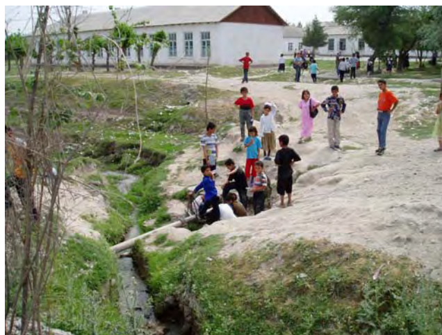
写真-10【メハナタバッド・ジャモアット、グロボッド村】 グロボット村小学校。井戸から6kmに位置しており、給水状況が悪い。生徒たちは送水管に開けられた穴から漏れる僅かな水を奪い合うように飲んでいる。
