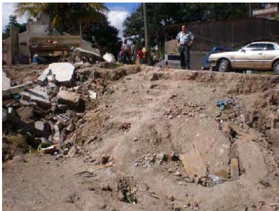
Deformación en el lado este de la parte central
