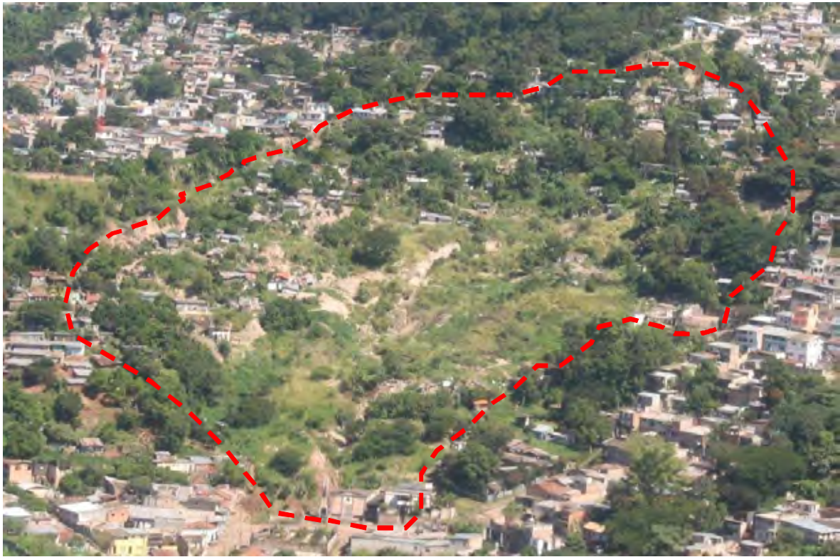
Panorama de deformación desde lo alto de cielo (antes del gran desplazamiento del bloque de tierra)
