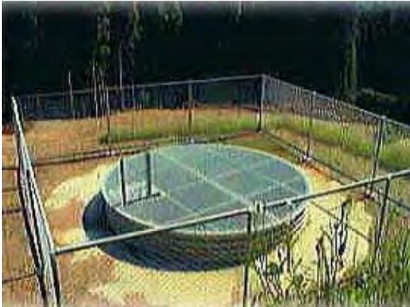
Foto-7: Foto de ejemplo: Aspecto exterior de pozo de infiltración (parte saliente del suelo).
