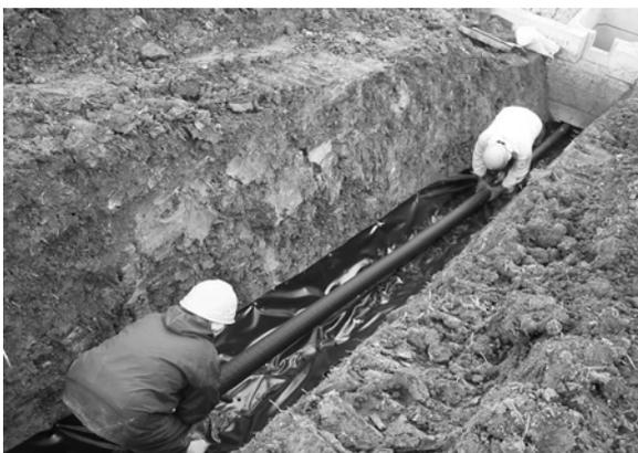
Foto-11: Foto de ejemplo: Instalación de tubos de drenaje en canales cerrados (primer piso) (canales cerrados y abiertos en 2 pisos)
