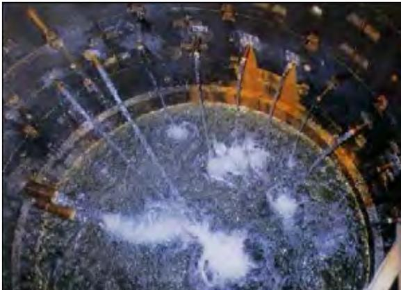
Foto-9: Foto de ejemplo: Estado de toma de aguas por los tubos de captación de agua al pozo de infiltración. Las aguas captadas, a través de los tubos de drenaje serán vertidas en el río pasando por el siguiente pozo de infiltración o canales.
