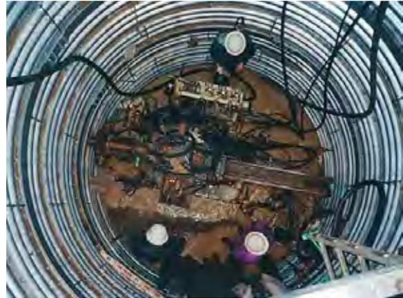
Foto-8 Foto de ejemplo: Interior de pozo de infiltración en construcción. Lo que se ve en el fondo es la máquina para perforaciones de captación de agua.
