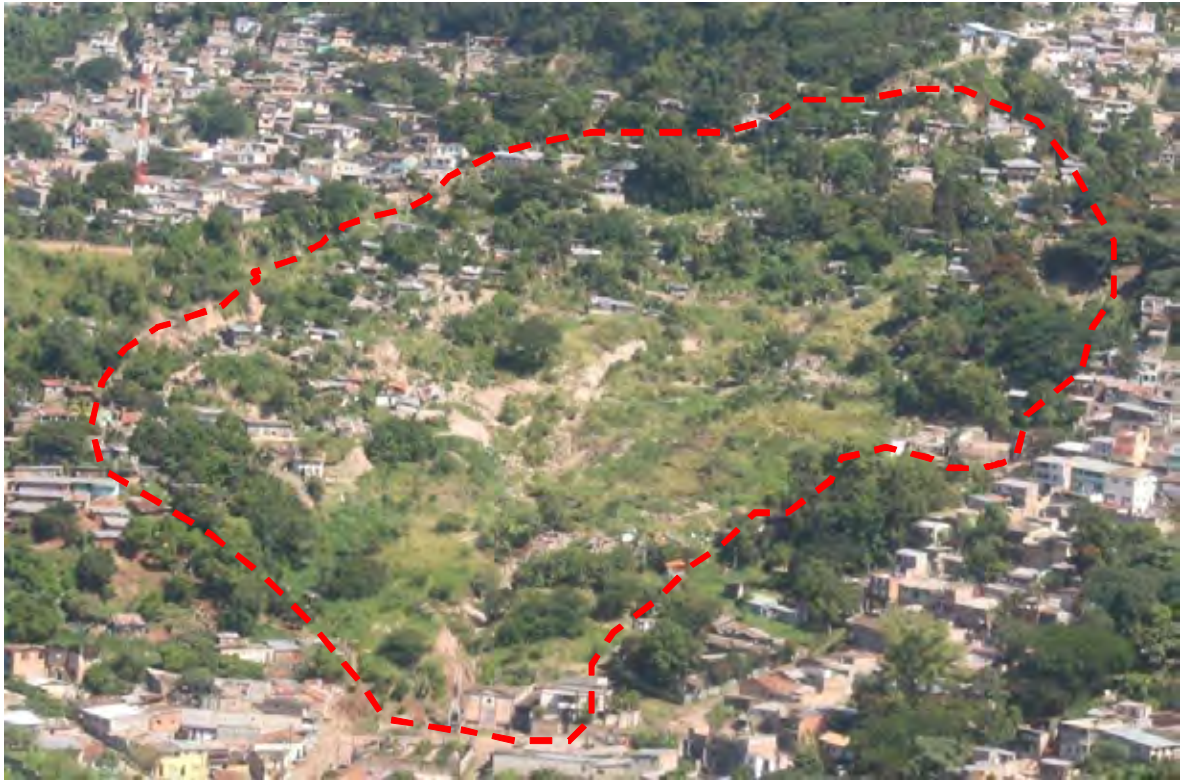
上空から見た変状発生範囲全景(2008年10月26日:大規模な土塊移動前)
