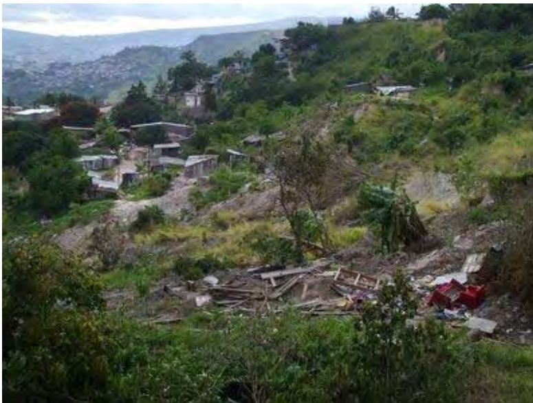
11月1日未明に滑落した東側ブロック上部の状況。 (11月3日撮影)
