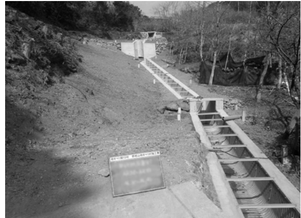
【写真-10】事例写真：水路
