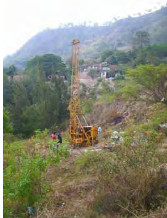
【写真-5】ボーリングによる地質調査状況(エル・レパルト地区)
