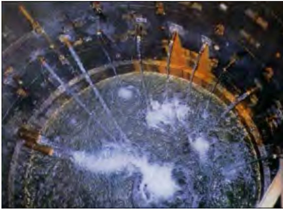
【写真-9】事例写真：集水管より集水井への集水状況。 集水された水は排水管を通して次の段の集水井または水路を通して川へ排水される。
