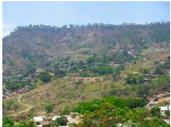
【写真-2】エル・レパルト地区地すべり全景。右側上方斜面から崩落し、中段斜面上の集落を押し流した。
