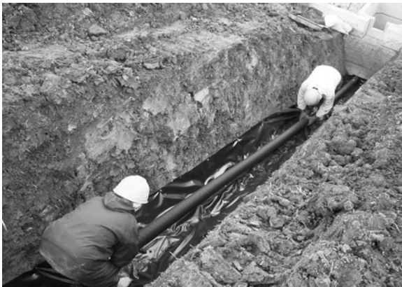
【写真-11】事例写真：明暗渠工(2 階建て水路)の暗渠部分(1 階部分)の排水管の設置工事状況
