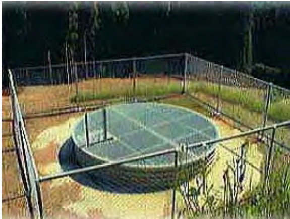
【写真-7】事例写真：集水井の外観(地上部分) 直径 3.5m、外側には侵入防止のためのフェンスを配置する。
