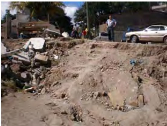
中央部西側の変状
