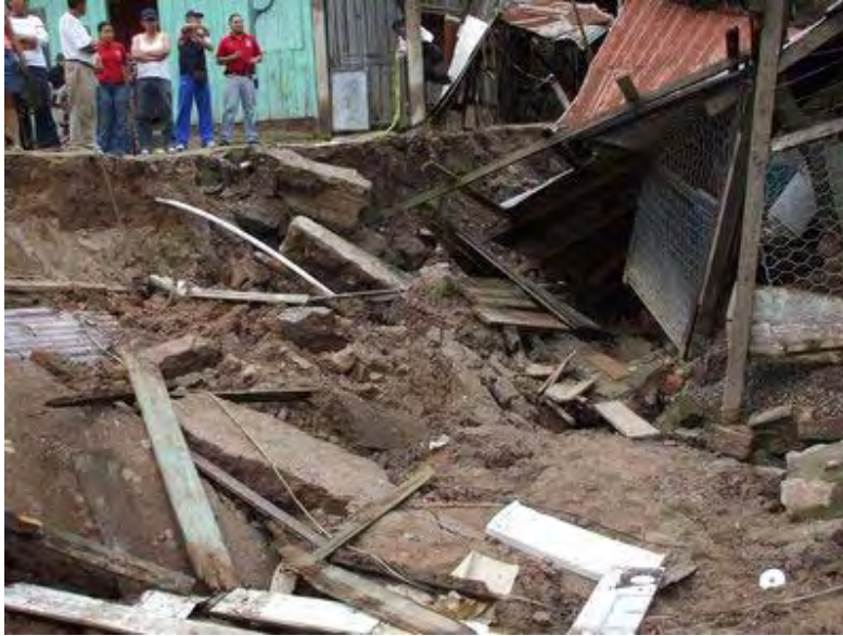
エデン地区に出現した滑落崖 (10月24日撮影)
