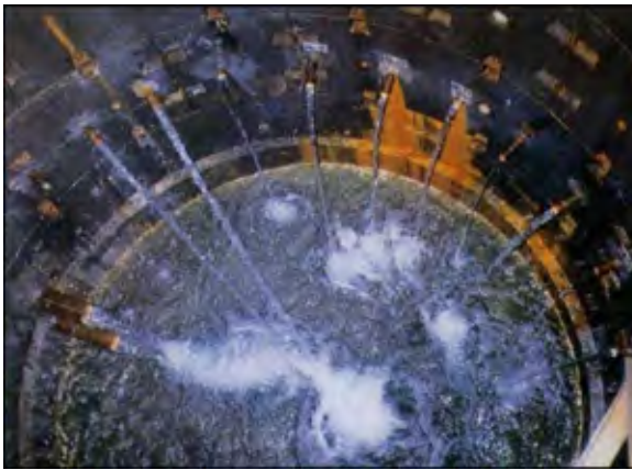
【写真-9】事例写真：集水管より集水井への集水状況。 集水された水は排水管を通して次の集水井または水路を通して川へ排水される。
