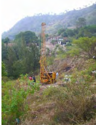
【写真-5】ボーリングによる地質調査状況(エル・レパルト地区)
