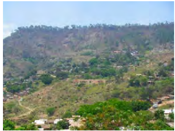
【写真-2】エル・レパルト地区地すべり全景。右側上方斜面から崩落し、中段斜面上の集落を押し流した。
