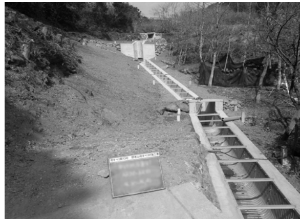
【写真-10】事例写真：水路
