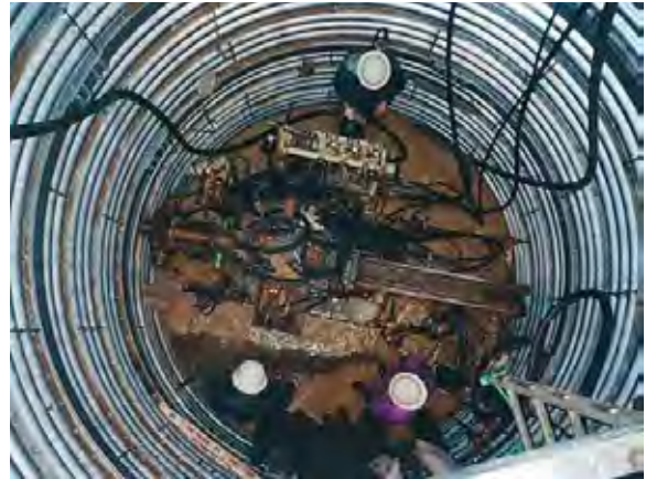
【写真-8】事例写真：施工中の集水井内部。 底部に見えるのは集水ボーリングマシン。
