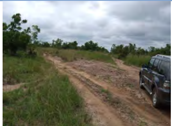
右側が新提示ルート〔Dufor Adidome（代替ルート2・3に通じる提示ルート）〕であり、左側が計画段階のR24号線（州道路）。両道路とも踏み道である
