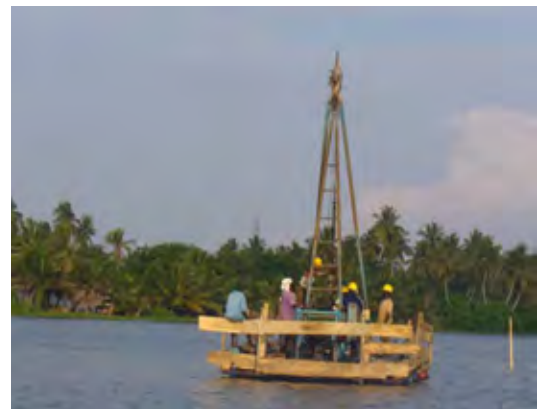
ガーナ地質コンサルタントによる ボルタ川での水上ボーリング実施状況
