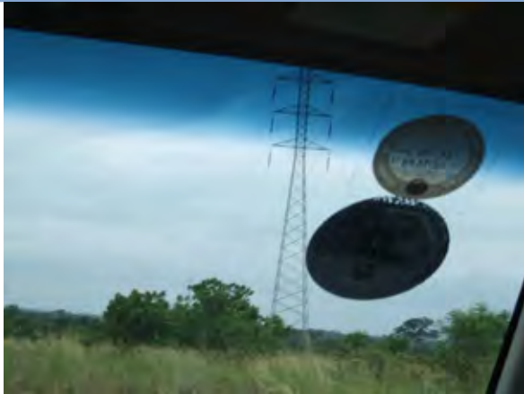
R24は計画段階の道路であり（ただし一部約1kmは道路のクリアランス・橋梁2基を工事中であった）、送電線建設のための工専用道路として建設されたものと考えられる
