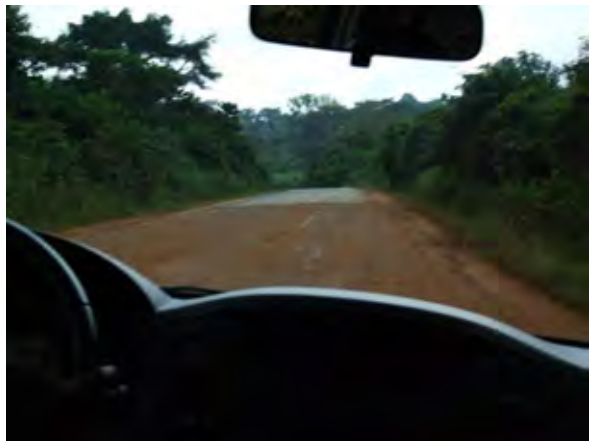
始点から15km地点：簡易舗装実施後の状況
