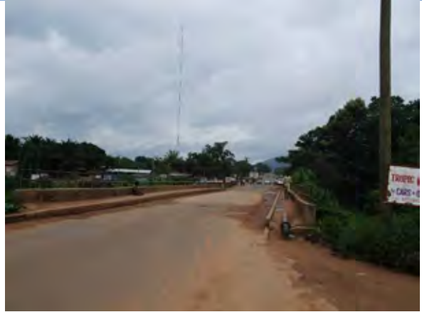
Hohoe市内の橋梁箇所
