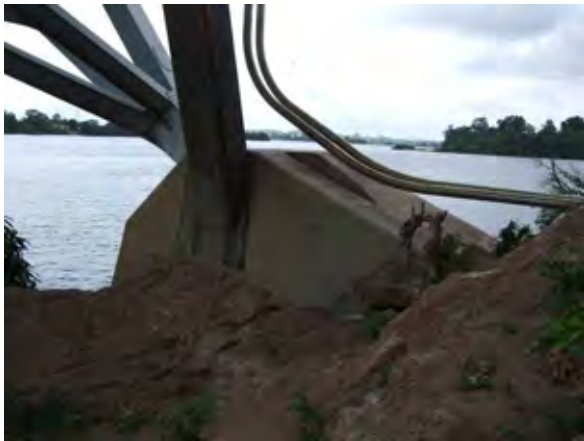
【アドミ橋】アーチ部分の橋長が約250mあり、極めて短い架橋区間に建設されている。また、上部工の反力を受ける橋台は岩が露頭している部分に計画されており、最も建設しやすい地点が選定されている。写真は岩の露頭を示す
