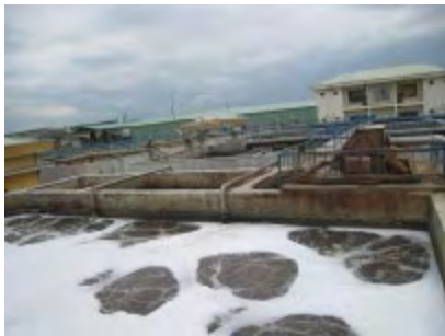
Hệ thống xử lý nước thải tại KCN Hòa Khánh
