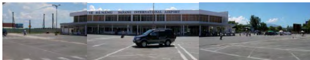
Sân bay quốc tế Đà Nẵng – Đang xây dựng nhà ga hành khách
