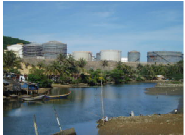
Nhà máy lọc dầu Dung Quất
