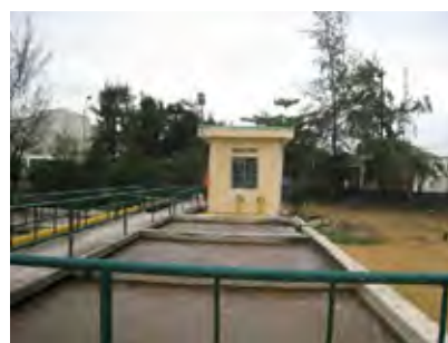
Danang IZ Treatment Facility
