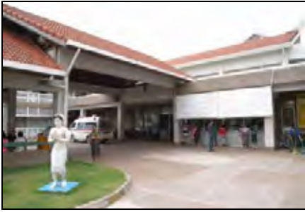
セタティラート総合病院 入口
