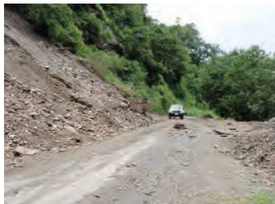
Dili-Liquiçá 間道路（岩石崩落）
