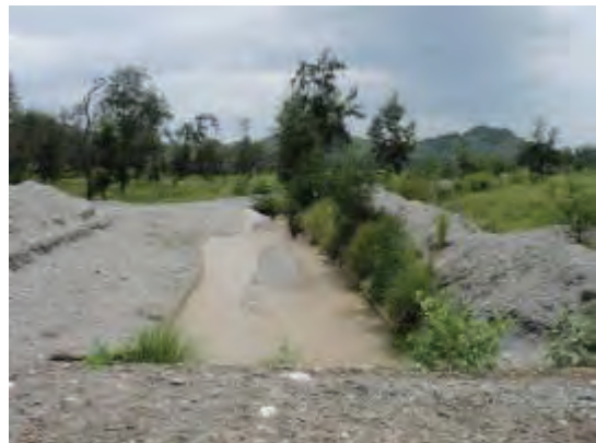
灌漑用幹線水路
