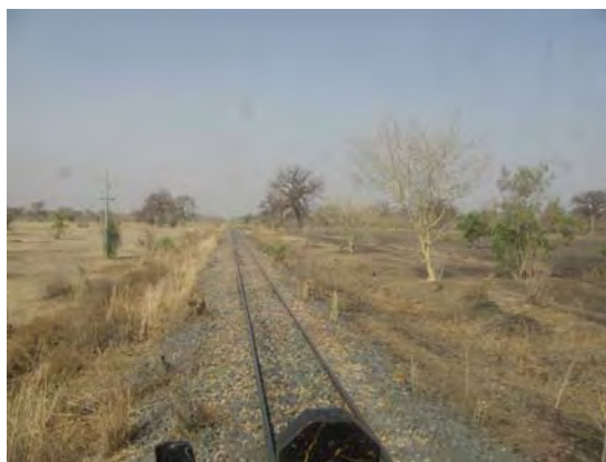
同左：灰色は補充されたバラスト 盛土の肩流出で法面にあふれる バラスト
