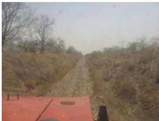
土側溝が残されている事例
