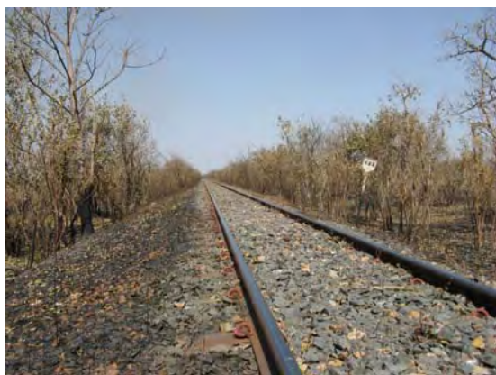
● Tambacounda 付近の軌道：パンドロール型締結装置
