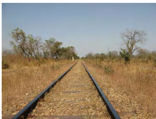
Kotiari～Bala 間の軌道 (26 kg/mrail)
