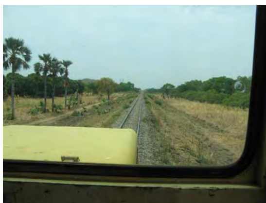
良好な盛土区間
