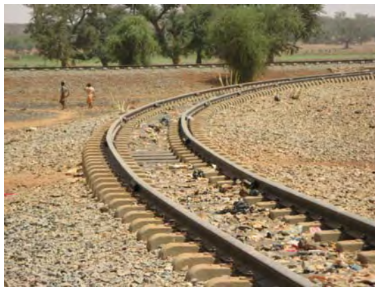
同駅三角線：機関車の方向転換用 レールの折れ角が不自然
