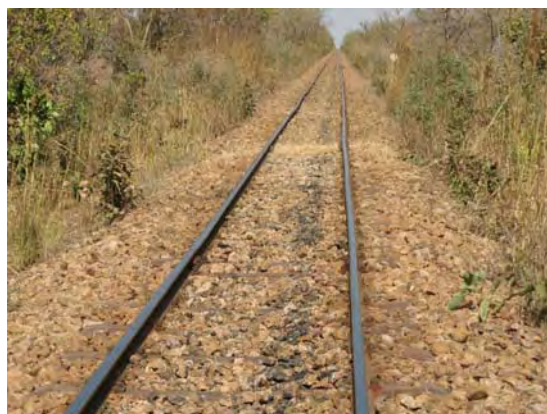
Kotiari～Bala 間の軌道 (26 kg/mrail)
