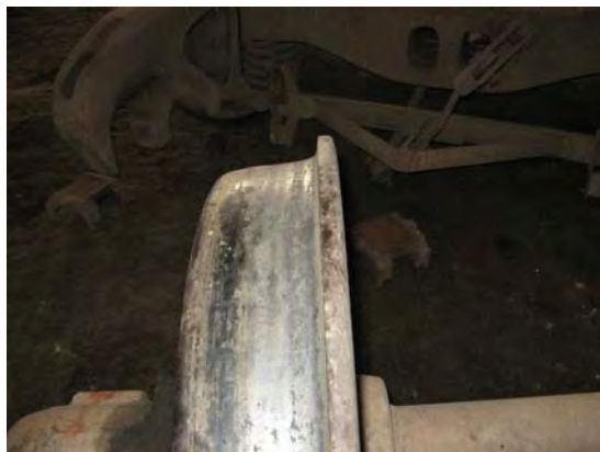
フランジ部の異常摩耗
