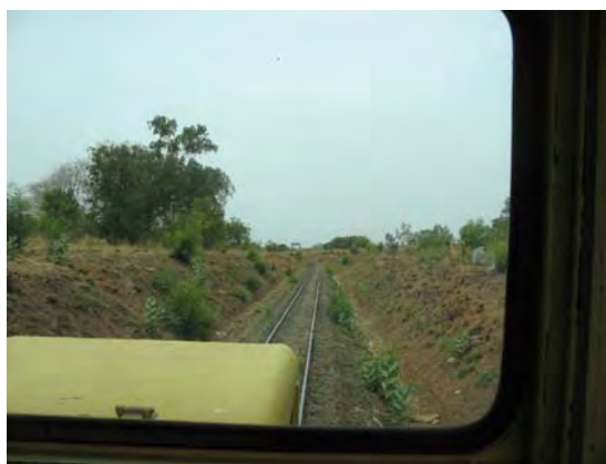
良好な切取区間
