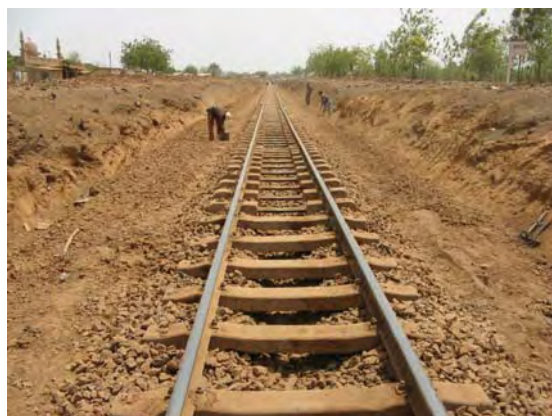
● 同駅を出て Bobo-Dioulasso 方の バラスト改良工事
