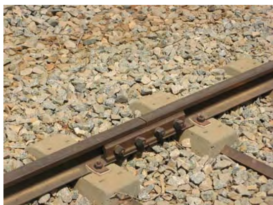
● レールのジョイント：良好
