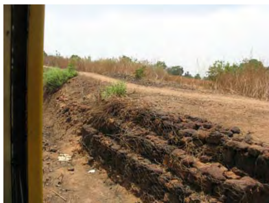
● 法面補修箇所
