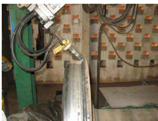
摩耗したフランジ部の盛金
