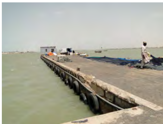
写真2 T型突堤の上流側 (突堤の端で冷蔵車から漁船に氷を積みこみしていた。岸壁は漁網を修繕場になっていた)
