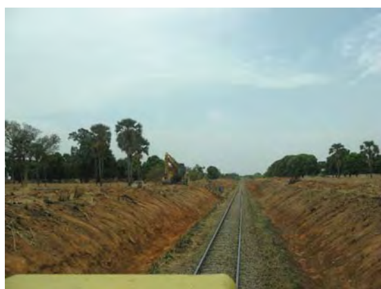
● 改修中の切取法面
