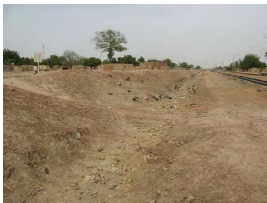
同駅構内の土側溝・線路
