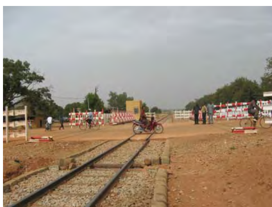
Bobo-Dioulasso 駅付近の踏切 2： 移動柵による踏切遮断
