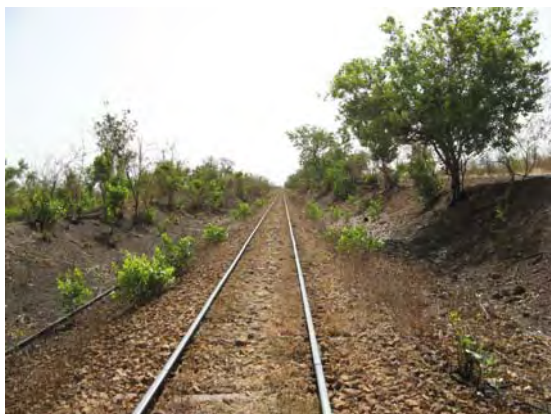
● Kotiari～Bala 間の軌道 (26 kg/mrail)
