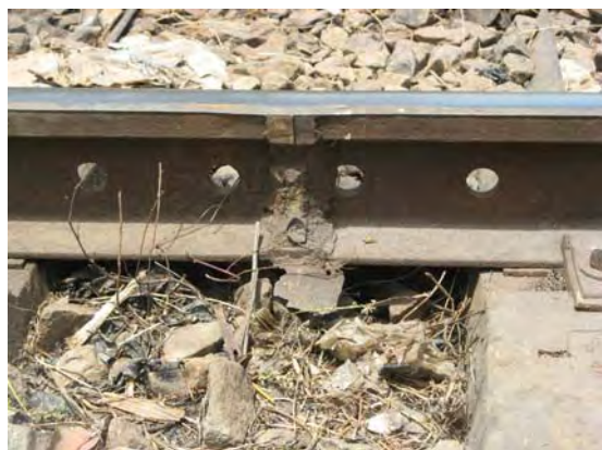
● レールの溶接継目
