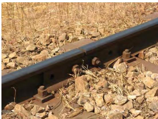
● Kotiari～Bala 間：26 kg/m rail の継ぎ目
