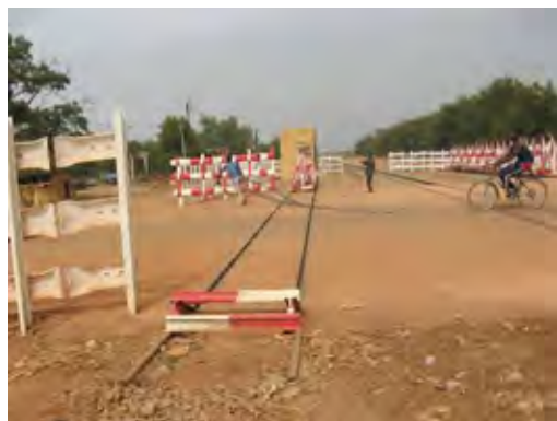
Bobo-Dioulasso 駅付近の踏切 （移動柵による踏切遮断）
