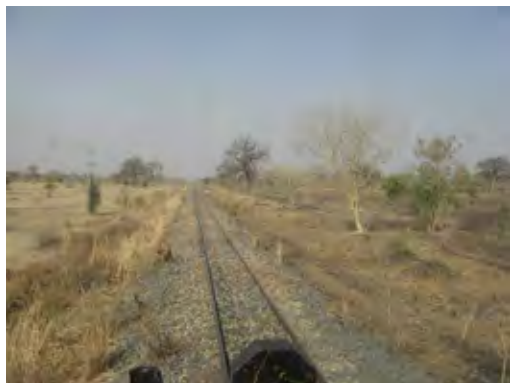
灰色は補充されたバラスト盛土の 肩流出で法面にあふれるバラスト
