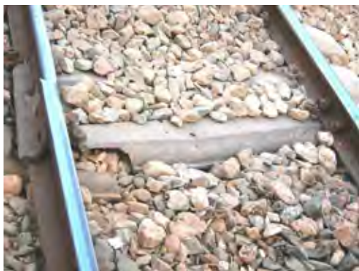
マクラギの破損・継目板のボルト脱落
