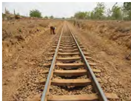
同駅 Bobo-Dioulasso 方の バラストクリーニング・法面補修現場
