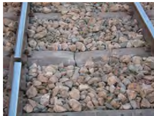
マクラギの破損・過大遊間
