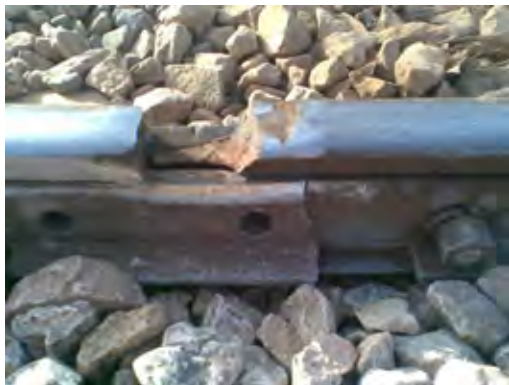
レール継目の欠損・継目板破損・ ボルト脱落
