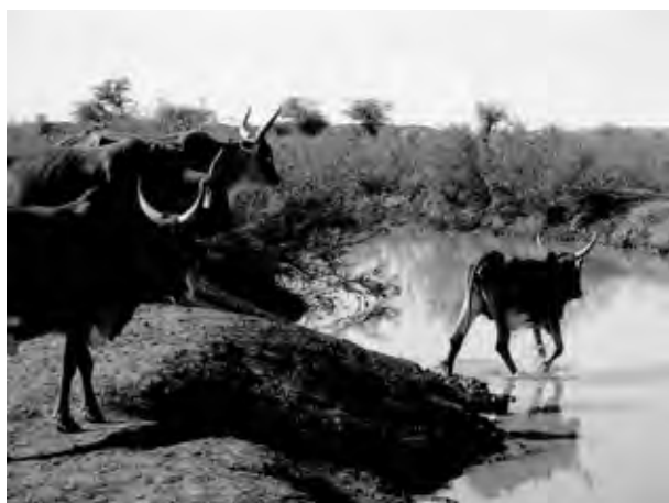
Canal endommagé par le bétail
