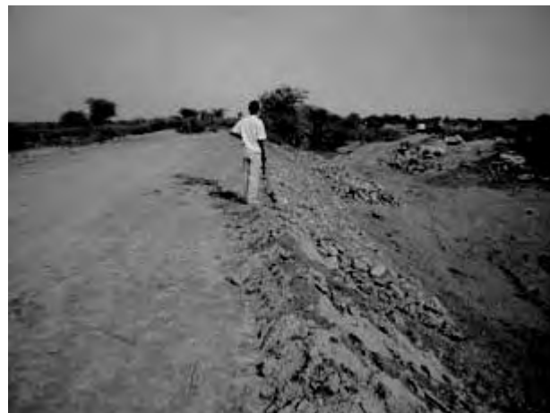
Digue en aval du pont après travaux sur le remblai
