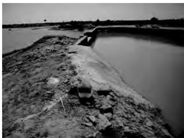
Digue après réparation
