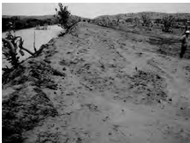
Digue renforcée (OA)
