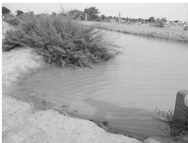
Aval du pont-aqueduc AD (rive gauche AD)
