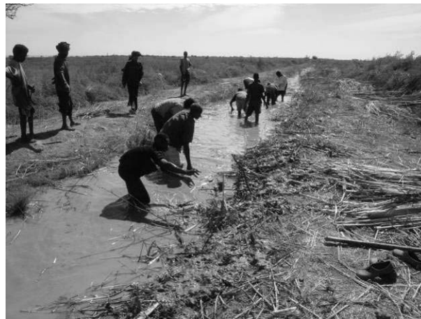
Curage (nettoyage des canaux)
