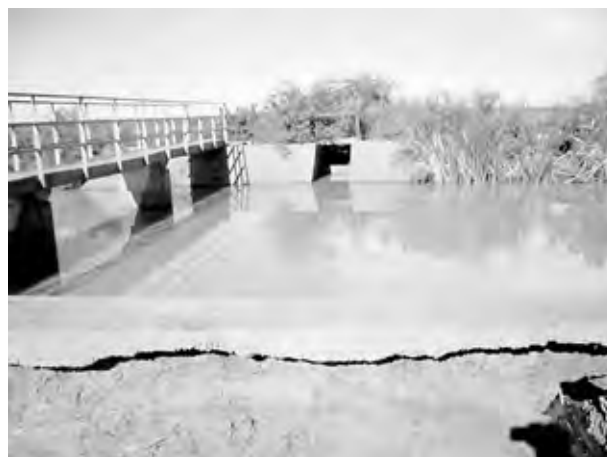
Main canal (AG)
