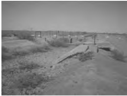
S9 幹線分水堰と余水吐（右岸側）
