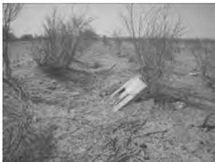
四次水路分水工(堆砂除去、盛土、鉄板ゲートが必要)
