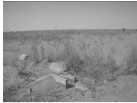
三次水路分水ボックス
