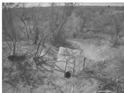
四次水路への分水工
