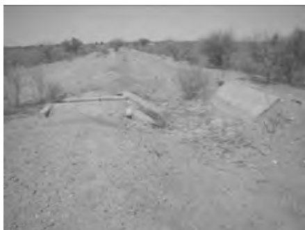
二次水路分水工
