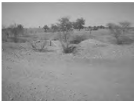
分水位調整堰
