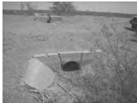
三次水路の道路横断工
