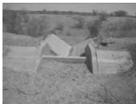
二次水路余水吐
