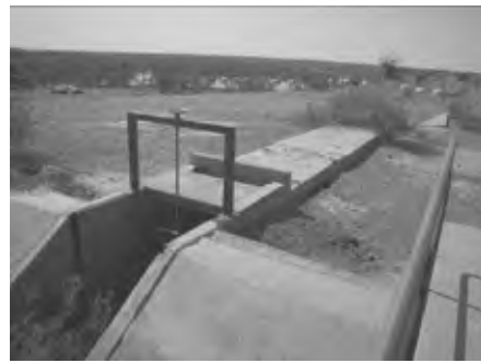
S9 幹線分水工(左岸側)
