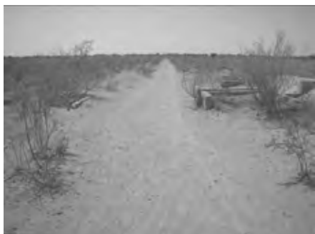
二次水路末端に沿う農道
