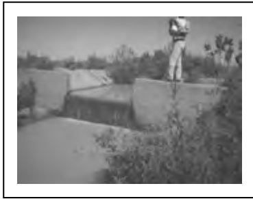
677m 地点の分水工チェック堰
