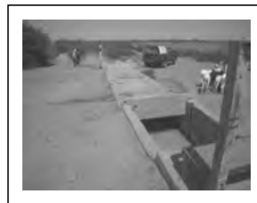
S27 分土工と下流二次水路
