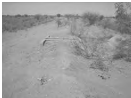
二次水路分水工
